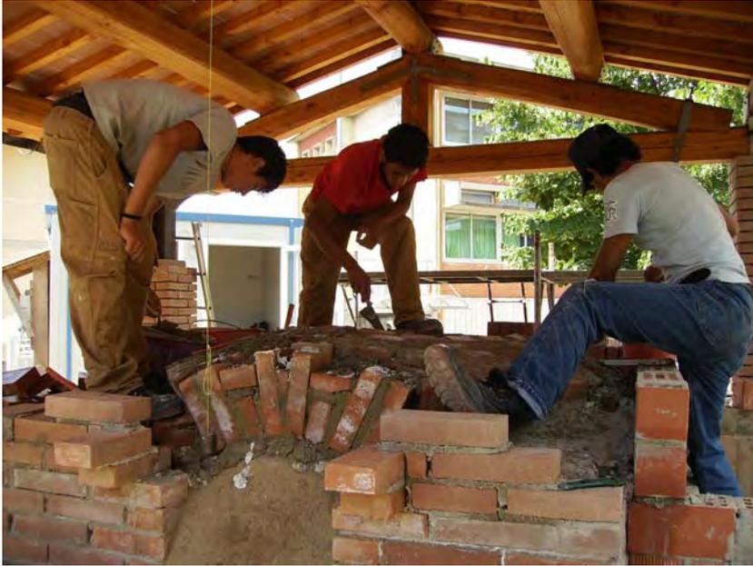
20 e 21. Fasi di ultimazione della volta di copertura del forno.
