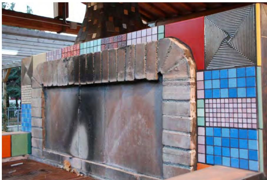
39. La zona griglie, in mattoni refrattari, non è sprovvista di un rivestimento di vivaci piastrelle in monocottura.
