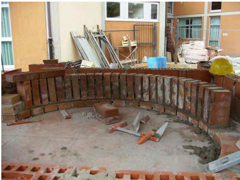
18. Il perimetro della camera interna del forno e la posa dei mattoni refrattari. 19. I primi mattoni, poggiati sulla centinatura di sabbia, per realizzare la volta ribassata del forno.
