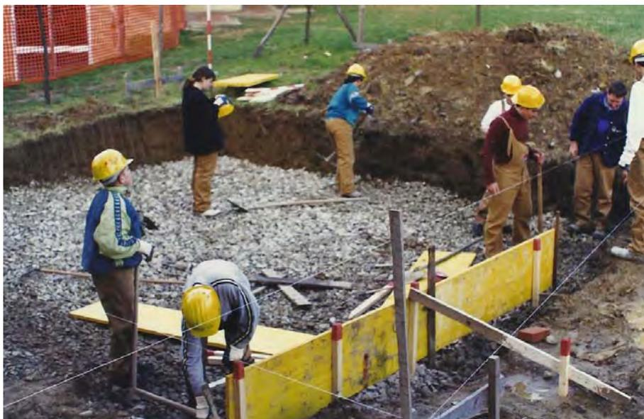
11 . Realizzazione delle armature per le fondamenta.
