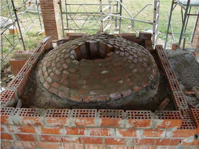
22. Chiusura della volta di copertura del forno.
